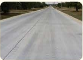
૧૨ મીટર : ૧૮ મીટર પહોળા RCC રોડ
